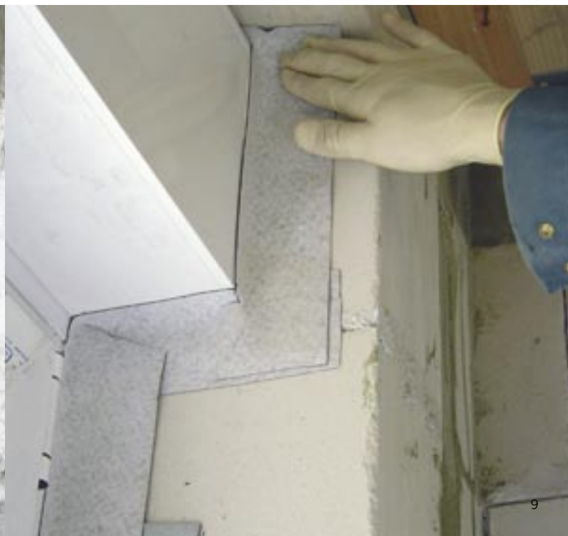
Abb. 6 Eckausbildung mit Fensteranschlussfolie am Rollladenkasten
